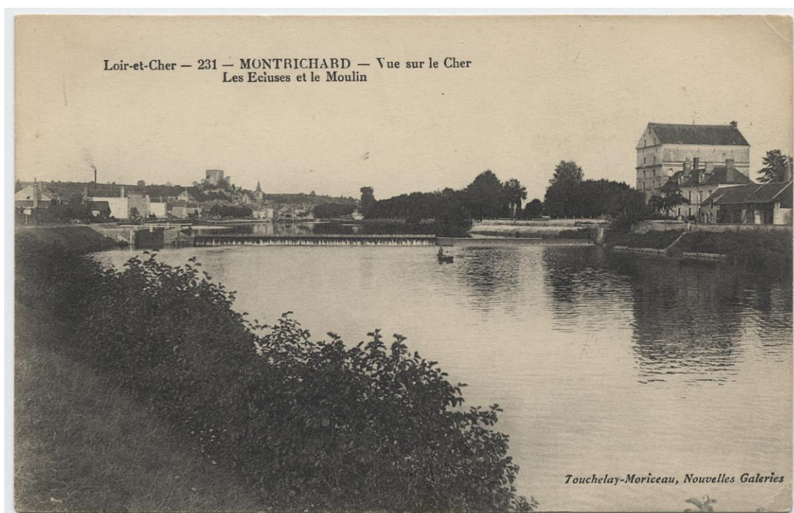
Le barrage et l'écluse de Montrichard, carte postale.
